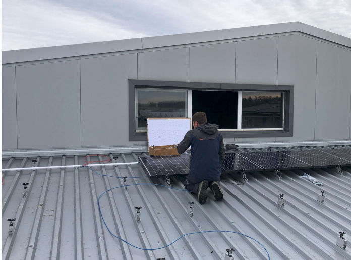
Montage der Unterkonstruktion
