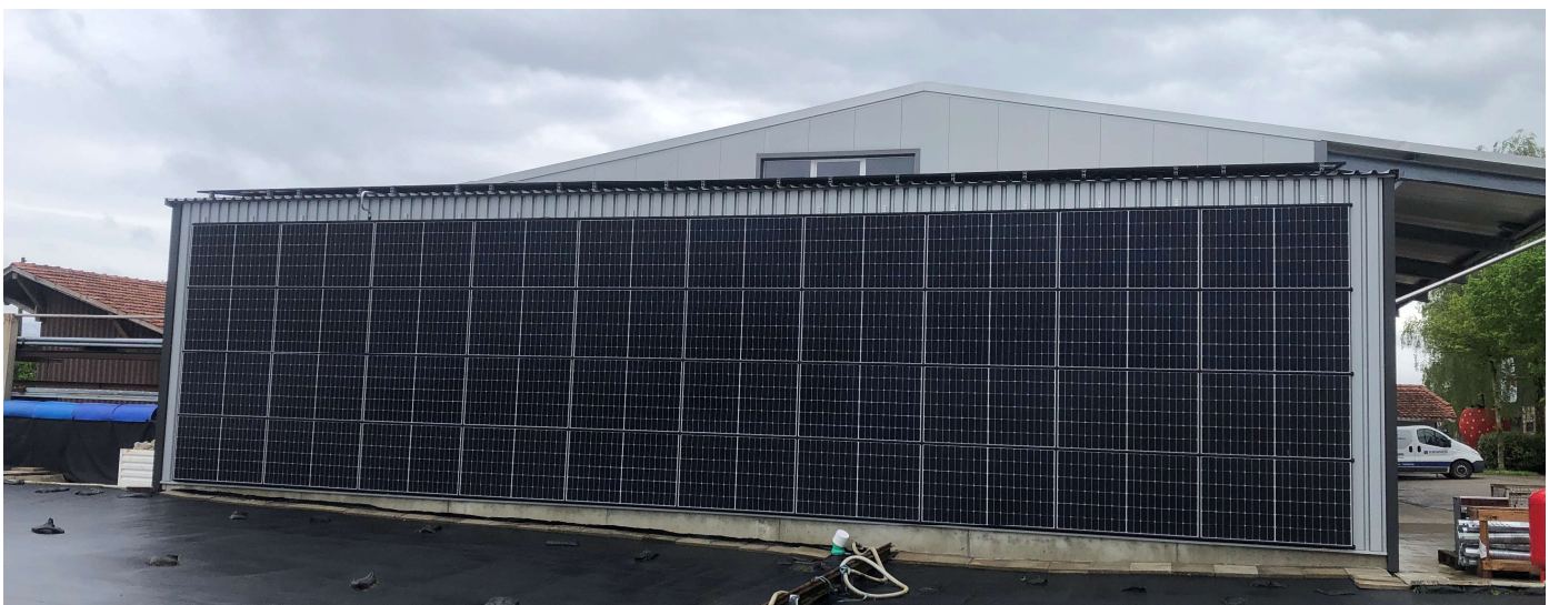
Wandanlage mit Einlegeschielen, ideal für die Produktion von Winterstrom
