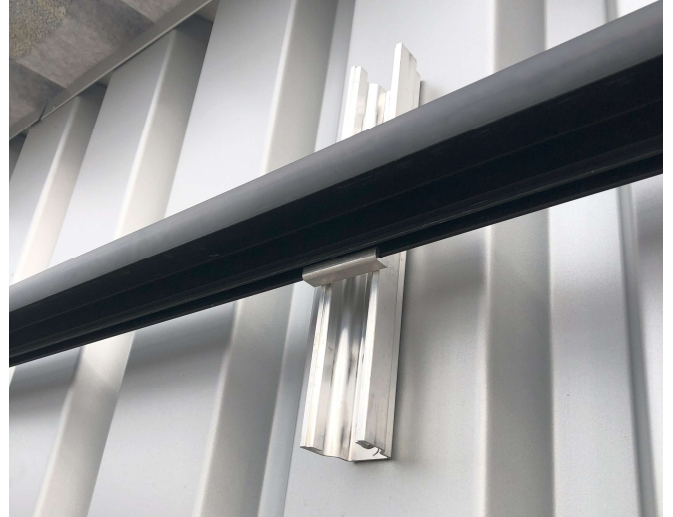
Unterkonstruktion Wand (Multirail K2)
