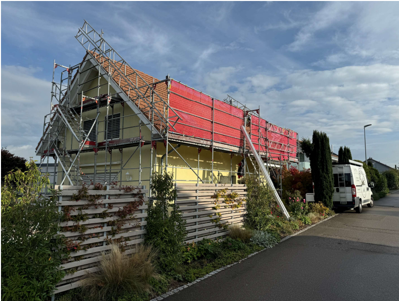
Mit dem Gerüst wurde auch die Fassade gestrichen
